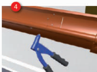
Заклепайте патентованными заклепками PREFA 4 x 10 мм, располагая их в крестообразном порядке (6 шт. заклепок для водосточного желоба ? 100 мм, 8 шт. заклепок для водосточного желоба ? 125 мм и ? 150 мм, 10 шт. для водосточного желоба ? 190 мм).
